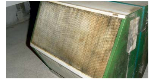
Nach fünfjähriger Betriebszeit sollte man bei einer Lüftung eine erste kostenlose Kontrolle durchführen lassen.
