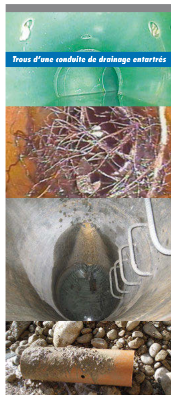
Entrée calcifiée dans un collecteur de boues Image ci-dessus: Croissance de racines
