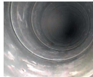
Regelmässige Wartung sorgt für Wohnkomfort und Werterhalt.
