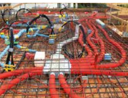
zVg: Helios Ventilatoren AG
