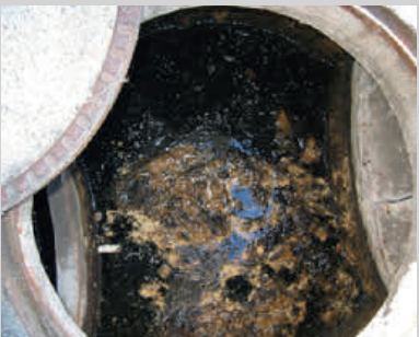
Abscheider trennen Stoff-Gemische. Stoffe, die nicht in die Kanalisation gelangen dürfen.
