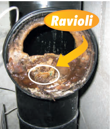
Spülstutzen eines Küchen-Fallstrangs, nicht gerade in einem vertrauenswürdigen Zustand
