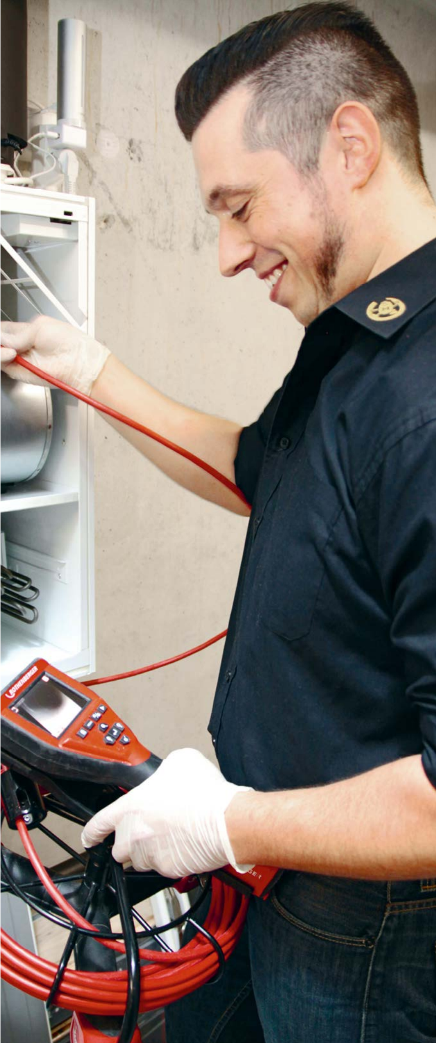
Im Auftrag einer Lüftungsreinigungsfirma kontrolliert Fachmann Helder Pires die Zu- und Abluftrohre eines Einfamilienhauses.
